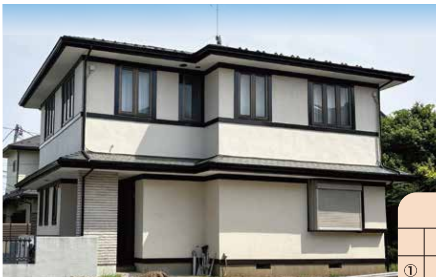
A邸 屋根・外壁塗装工事完了
